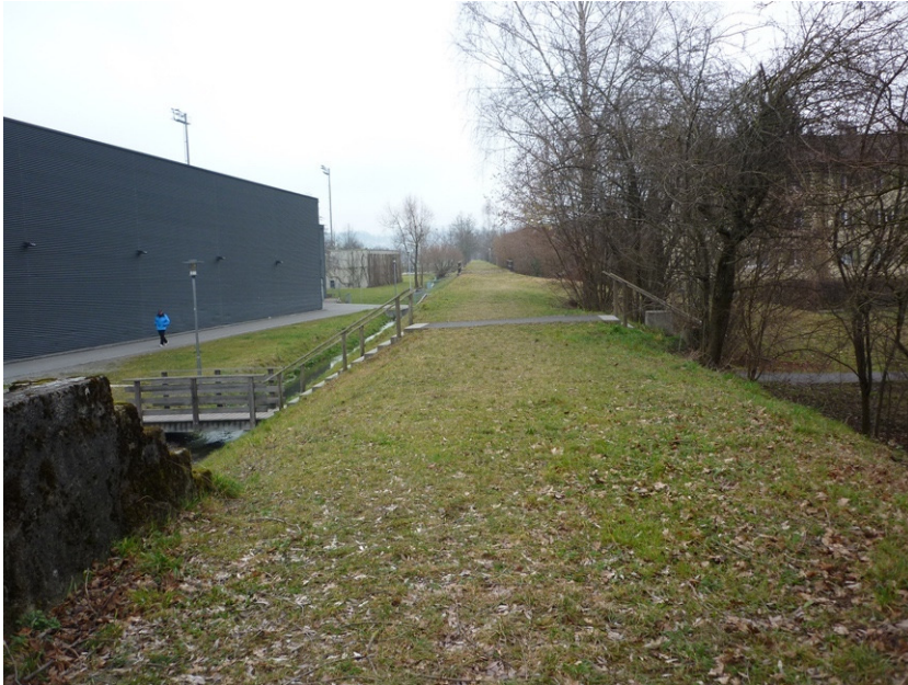
Abbildung 11: Damm ab der General-Guisan-Strasse bis Feldstrasse
