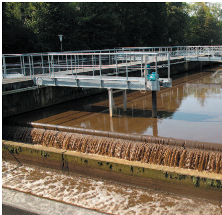
Biologisches Reinigungsbecken der Kläranlage Schönau
