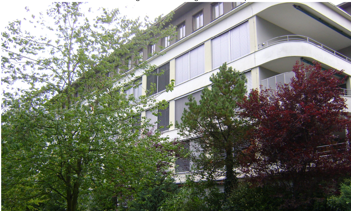
Abbildung 11: Foto des Spitaltrakt-Südflügels (Baubereich D1), Stand September 2013
