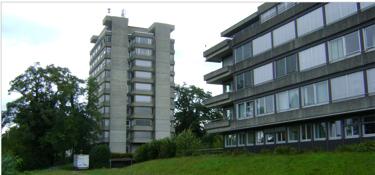
Abbildung 10: Foto des Personalhochhauses, Stand September 2013
