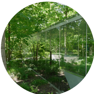
Referenz Fluchttreppe: Novartis Gelände Basel
