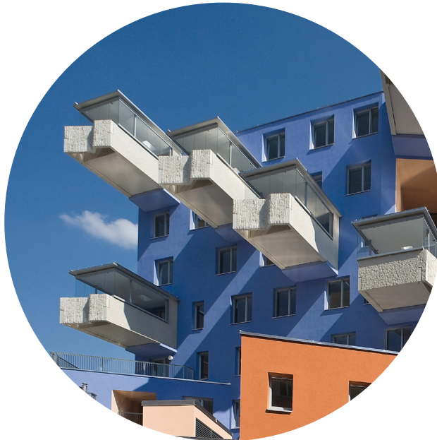
Dominant auskragende Bauteile
