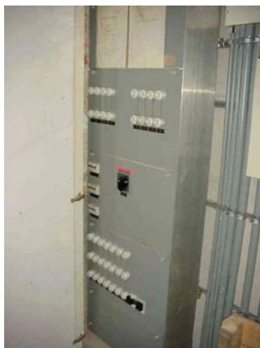
Etagentableau FG Treppenhaus rechts B+A Nr. 2007.28
