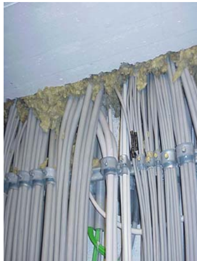
Brandabschottung Dimmerraum
