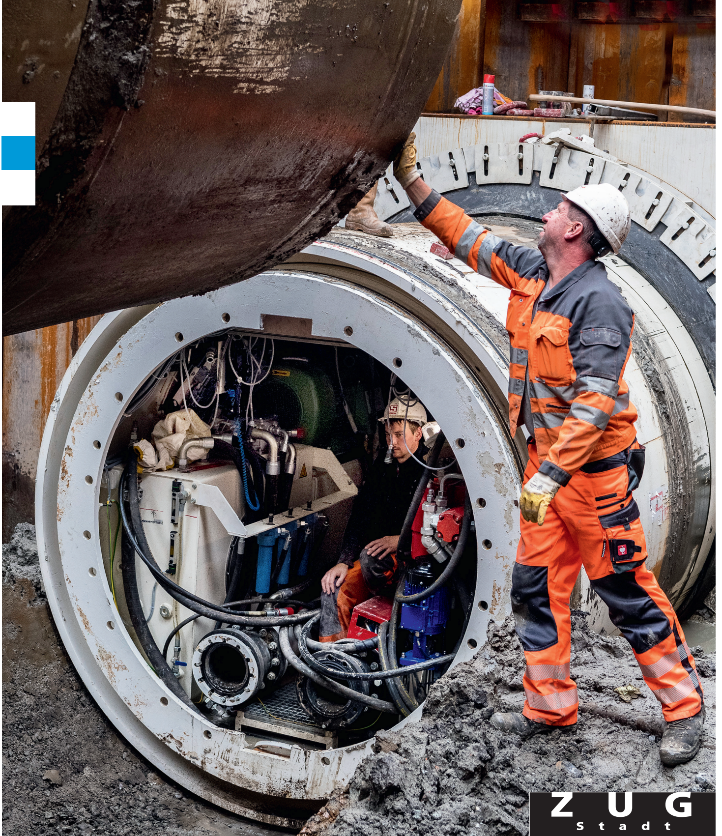
Generationenprojekt Vorflutleitung Zugersee: Nach der Ankunft im Zielschacht wird der Bohrkopf entfernt.
