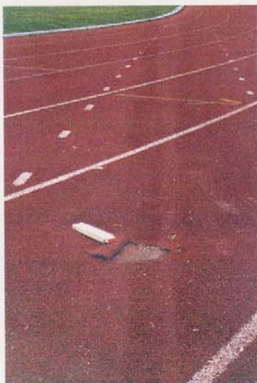
Schäden am Kunststoffbelag (Laufbahn).
