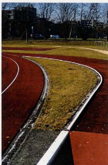
Rasenfläche wird neu durch Kunststoffbelag ersetzt.
