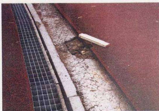
Schäden am Kunststoffbelag (Laufbahn).
