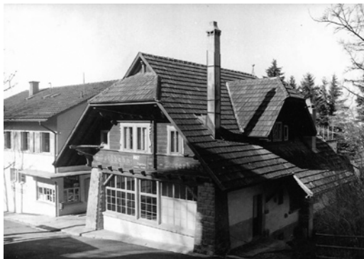
Abb. 34: Der Anbau mit Restaurant bekam während des Umbaus 1960 u.a. ein neues Dach, Aufnahme vor 1971/72 [19].
