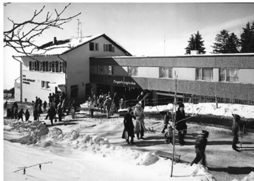
Abb. 35: Das alte Bergstationsgebäude wurde durch einen 70er-Jahre-Riegel ersetzt, Aufnahme nach 1971/72 [19].
