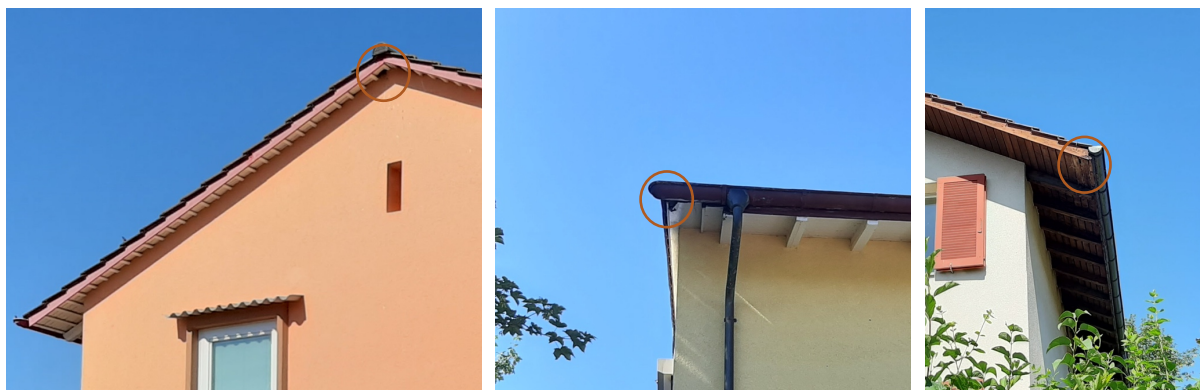
Abb. 2: Gebäude mit potenziell geeigneten Nischen / leeren Nistkästen wurden im Inventar als «Verdachtsgebäude» aufgenommen (hier anhand von Beispielen an der Gibeleichstrasse 75, 62, 64 in Opfikon).
