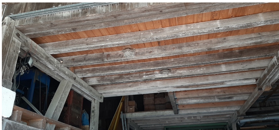
Abb. 5: Typische Nester von Rauchschwalben an den Holzträgern innerhalb von Ställen
