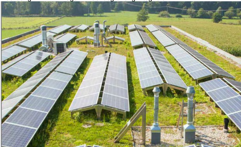
Abbildung 21: PV-Anlage in Dachbegrünung integriert
