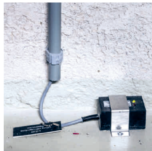
Die Wassersensoren schlagen bei der kleinsten Pfütze Alarm.
