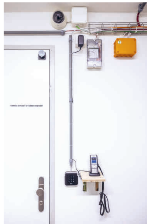
Überwachungskameras, Sicherheitstüren und eine Alarmanlage schützen die Dokumente.
