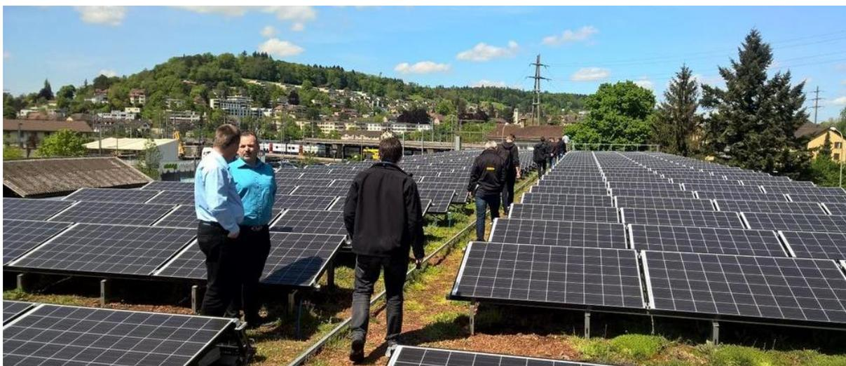
Abbildung 34: Referenzbild Solardach mit extensiver Dachbegrünung (Quelle: a777.ch)
