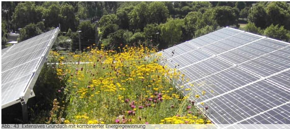
Abb.: 43 Extensives Gründach mit kombinierter Energiegewinnung
