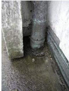
Dachwasser wird in Betondecke horizontal zur Gebäudeecke geführt
