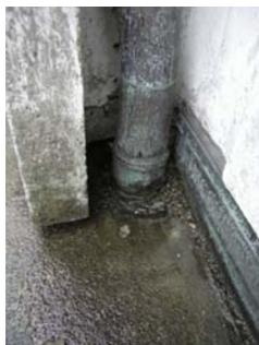
Problematisches Detail der Steildachentwässerung. Sichtbar sind das Ablaufrohr, der Gussasphalt und die Aufbordungen der Kupferbleche
