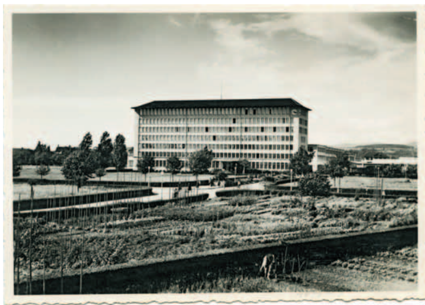
Das Verwaltungsgebäude der damaligen Landis & Gyr nach der Fertigstellung 1944.
