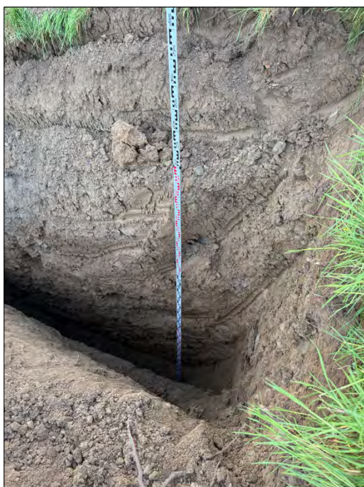
Baggerschlitz Nr. 04/25 auf Endtiefe
