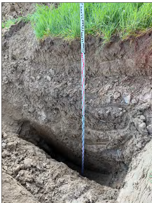
Baggerschlitz Nr. 03/25 auf Endtiefe
