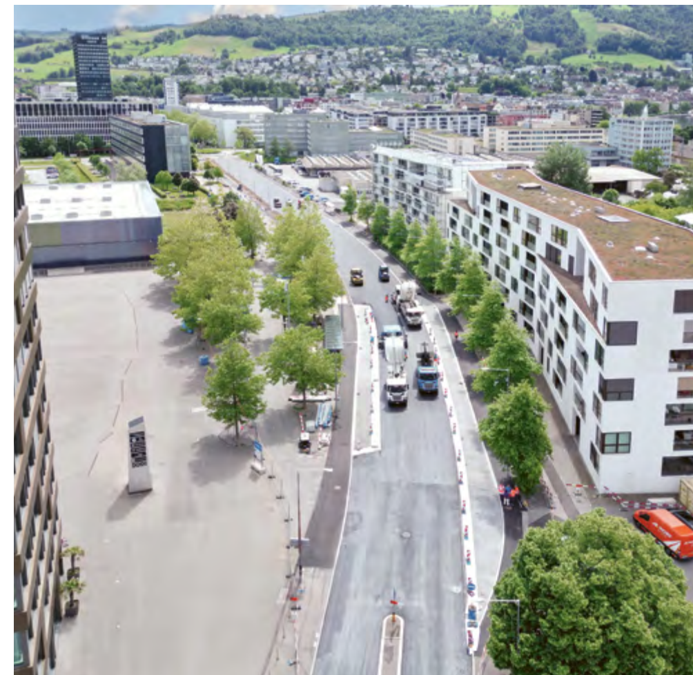
Letzten Sommer endete die Sanierung der General-Guisan-Strasse. Die Wanne auf der Strasse vor dem Eisstadion wurde aufgeschüttet und mit einem lärmarmen Belag versehen.
