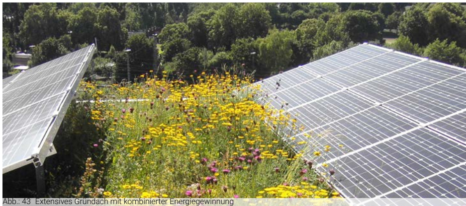
Abb.: 43 Extensives Gründach mit kombinierter Energiegewinnung
