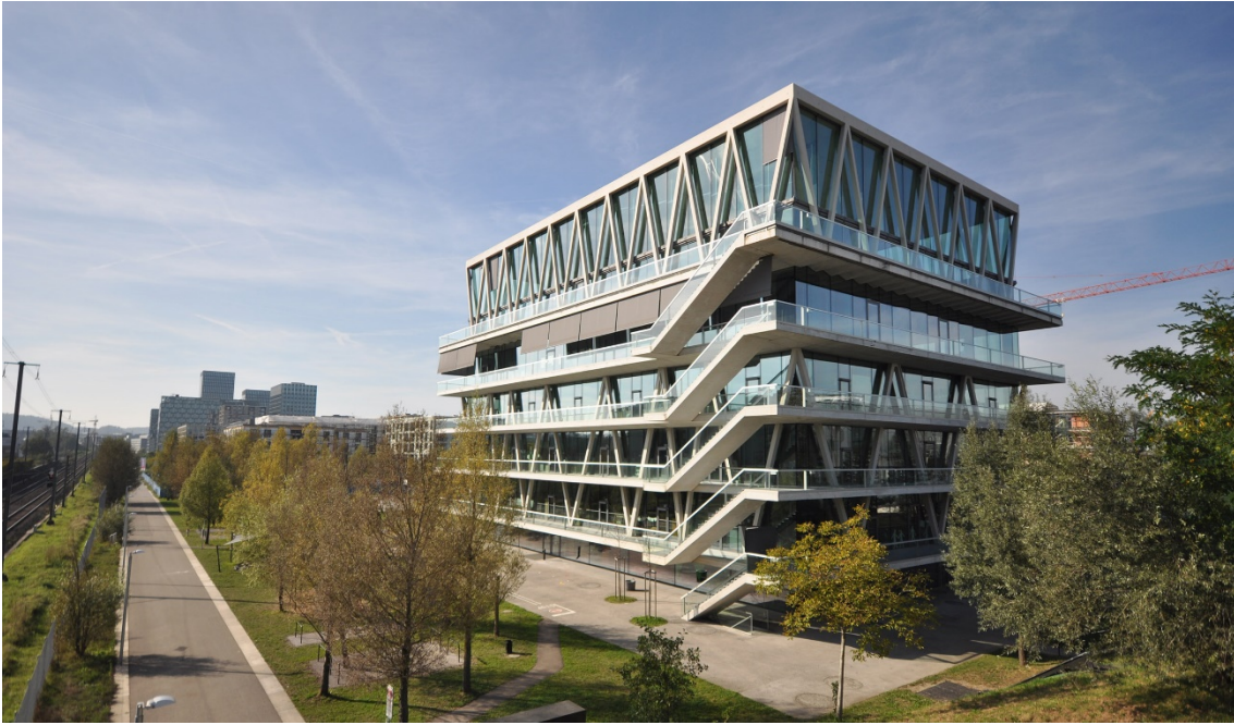
Beispiel 1: Schulhaus Leutschenbach (Stadt Zürich)
