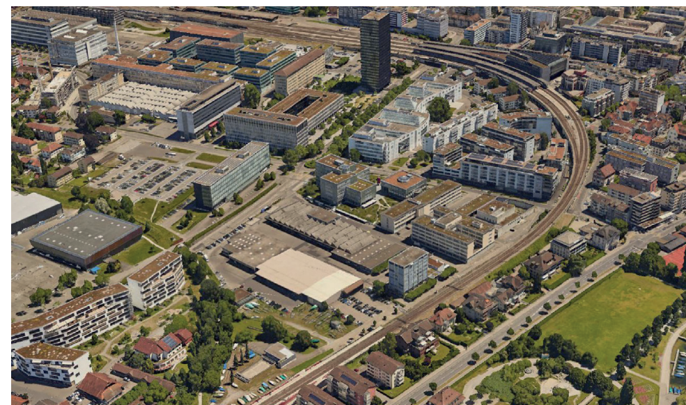
Luftansicht des heutigen Areals (Bildmitte, Quelle: Google Earth).
